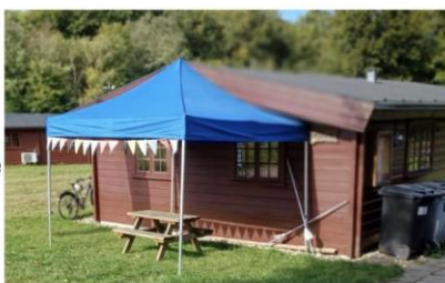
Reparation af endegavl på hytte
